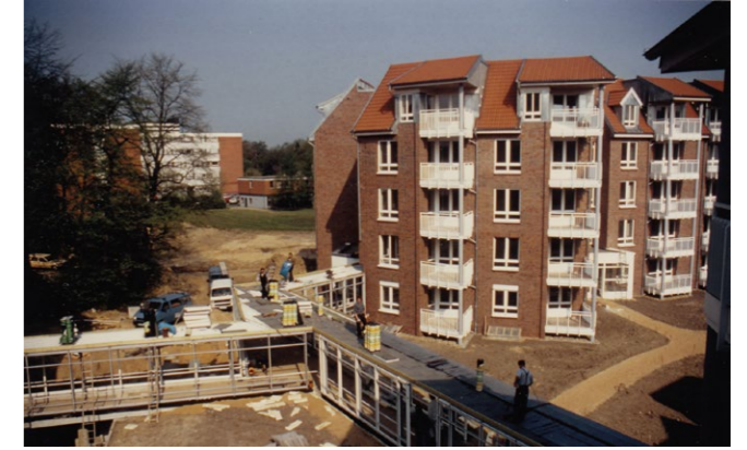
Die Glasgänge entstehen
