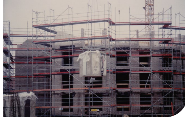
Die Residenz im Rohbau
